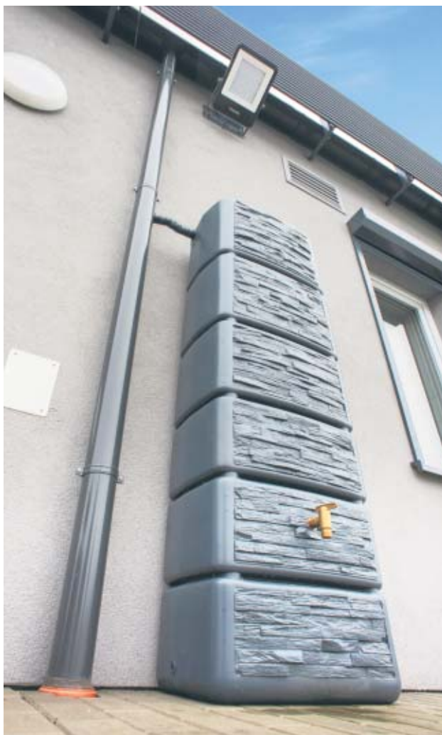
Zbiornik naziemny przy przedszkolu „Justynka” w Stawiszynie, zrealizowany w ramach zadania pn. Wykonanie systemu magazynowania wody opadowej przy Przedszkolu Samorządowym w Stawiszynie
