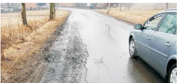
USZKODZONA NAWIERZCHNIA
